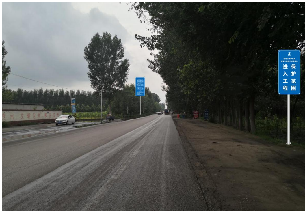
图 5-12 3 号警示牌现场安装效果, 标牌垂直路面埋设
