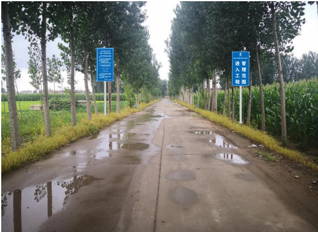
图 5-10 2 号警示牌现场安装效果，标牌顺路面埋设
